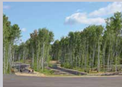
Строительство лыжероллерной трассы в Центральном районе г. Челябинска» МКУ «ЧЕЛЯБСТРОЙЗАКАЗЧИК»
