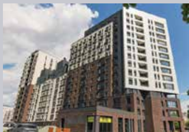
Жилой дом: «ELEVEN» В ЖК «Лесопарковый» ООО СЗ «Комфортная среда»
